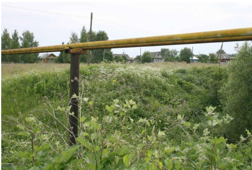
Рис. 1.1.7-21. Наружная прокладка газовых сетей
