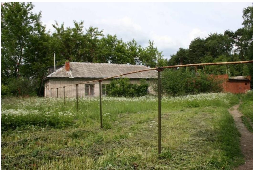
Рис. 1.1.7-20. Наружная прокладка газовых сетей
