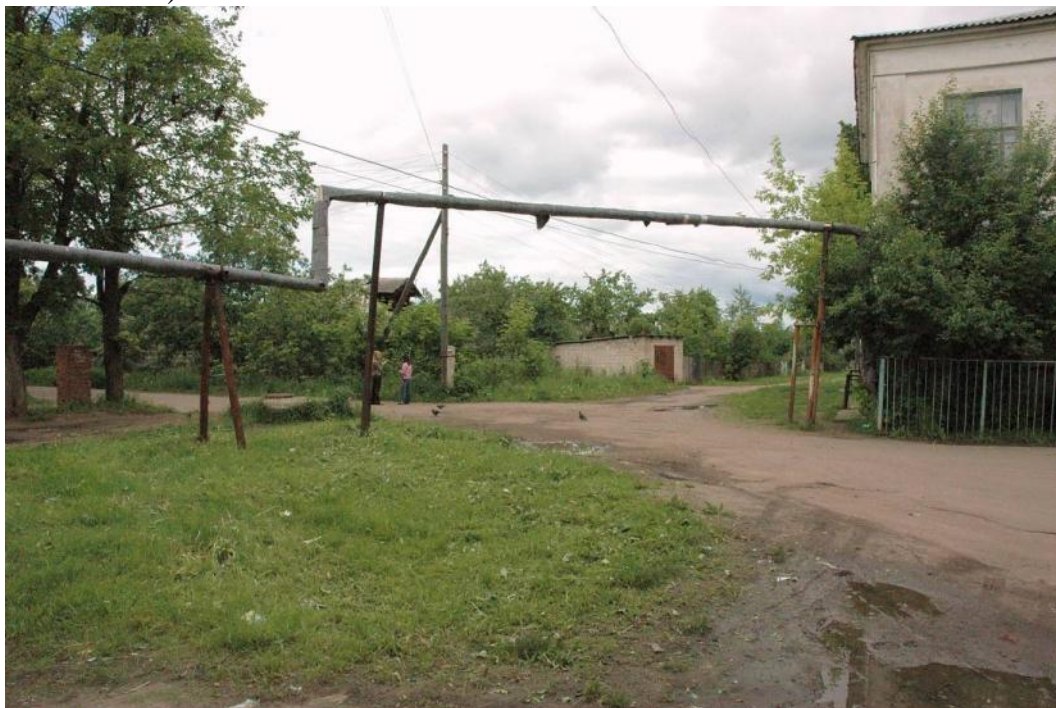
Рис. 1.1.7-19. Наружная прокладка тепловых сетей
